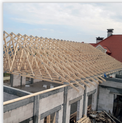
Wiązary dachowe na sali weselnej
