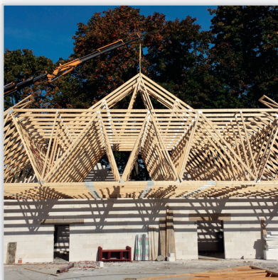
Wiązary dachowe na budynku handlowo-usługowym Rozpiętość: 24 m
